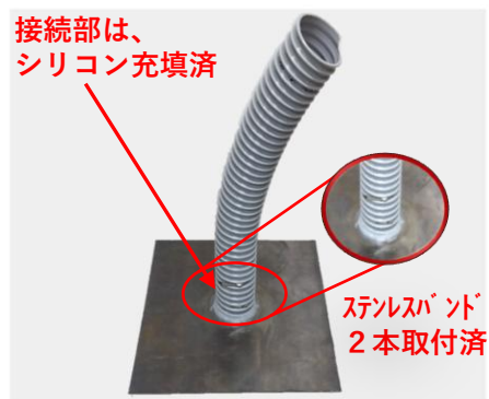
ジャバラ取付済鉛ドレン
